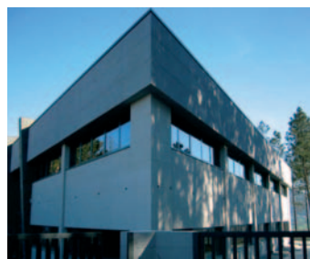
Data Center Comunitel
