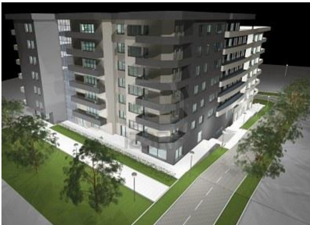
Figura 18: O Edificio Dixital no contexto da súa contorna.
